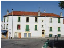
Rue de la Division Leclerc 5 logements
