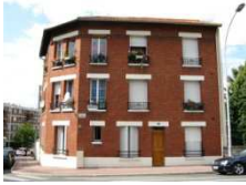
Rue du Paroy 7 logements
