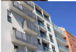
Rue Jeanne d'Arc 42 logements
