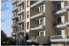
Groupe Auguste Delaune Rue du colonel Fabien 171 logements
