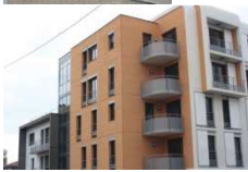
Résidence Allende Rue Allende 35 logements
