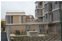
Les Carriers Rue Kleynhoff 24 logements
