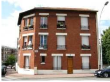
Rue du Paroy 7 logements
